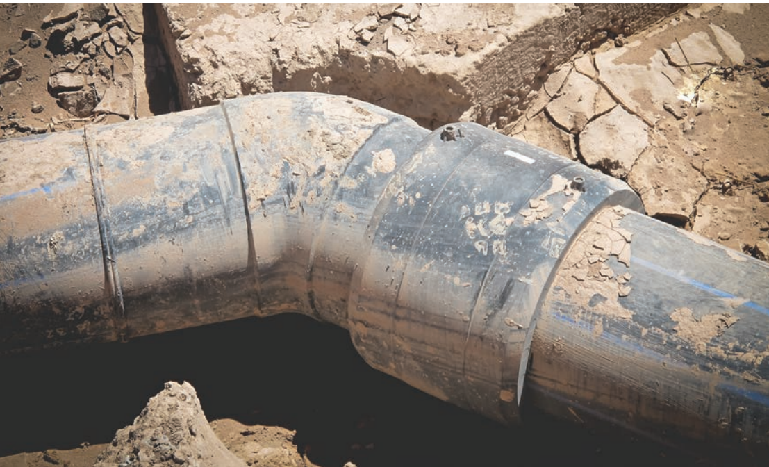
WORK // WATER DISTRIBUTION NETWORK – PROYECTO LA PORTADA LOCATION // ANTOFAGASTA
